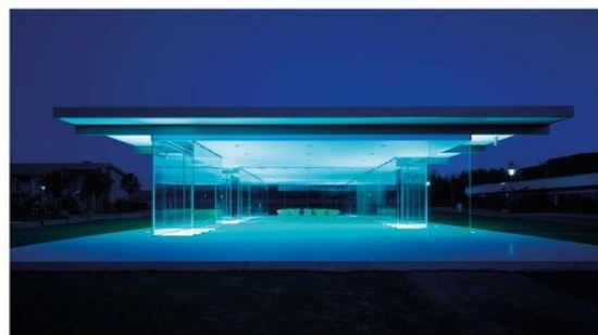
Das Pavillon hat eine sehr interessante Beleuchtung. Die Stelen sind durch gebündeltes Licht überflutet, die hintere Wand ist durch gebündeltes Licht überflutet. Die vertikalen Treppe bildet das Wegweiser in die überflutete Deckenfläche.
